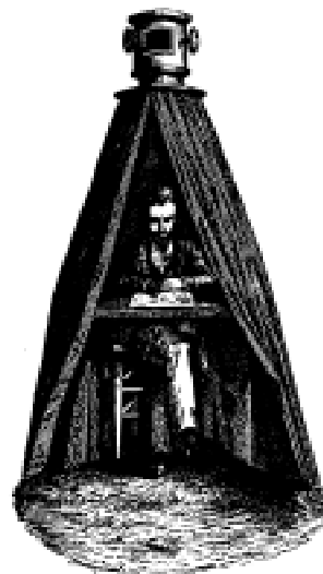
図 1.4 携帯用のサント型カメラ オブスキュラ [J. Hedgecock, "The book of Photography", Ebury Press (1906), p.18]
